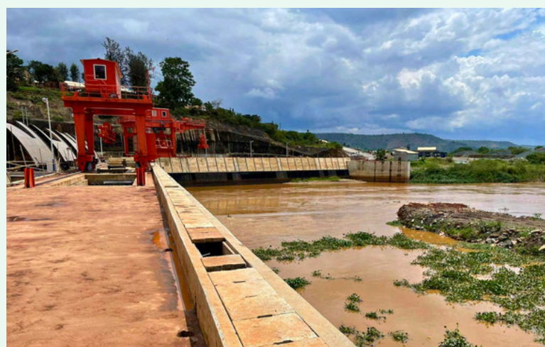
Projet hydroélectrique régional des chutes de Rusumo (Rwanda). © Anders Jagerskog/CIWA
